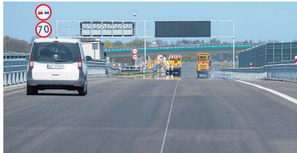
W tej chwili na S19 pod Kockiem trwają prace wykończeniowe, malowane jest oznakowanie poziome
