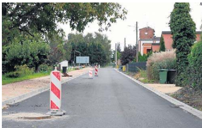
Przebudowa ul. Magazynowej w Lwówku jest już na ostatniej prostej
