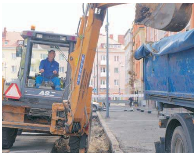
Pracownicy spółki ZWiK rozpoczęli modernizowanie infrastruktury wodno-kanalizacyjnej w Rynku
