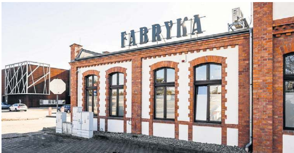
Najwyższa dotacja trafiła na odbudowę Fabryki Lloyd'a
