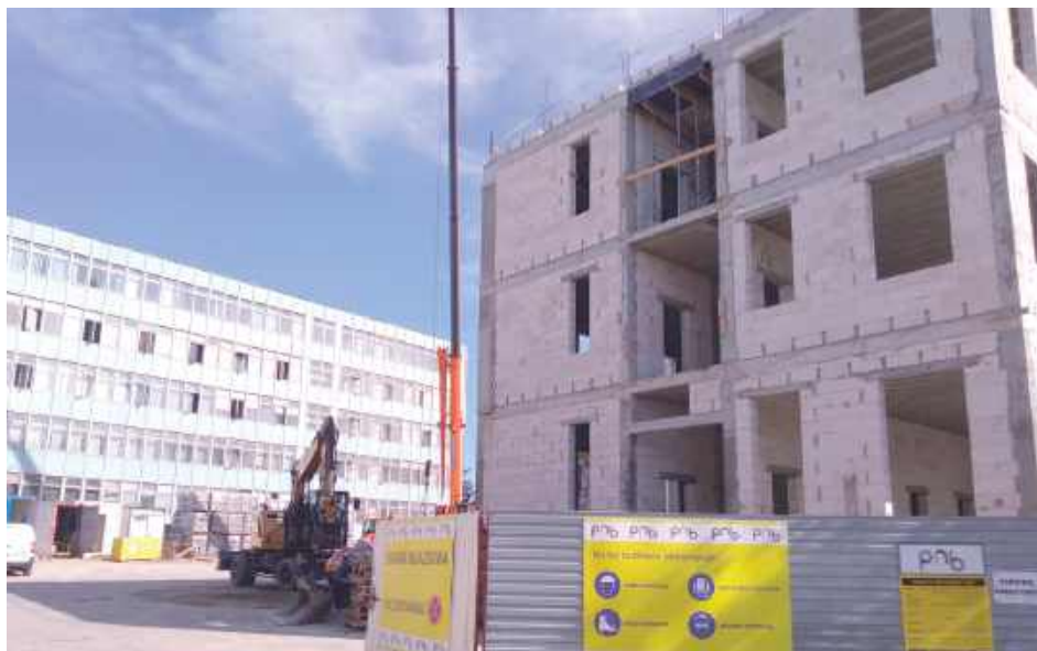
Przyspiesza budowa nowej siedziby starostwa z planowanymi nakładami na 2025 rok w wysokości 20,30 mln zł
