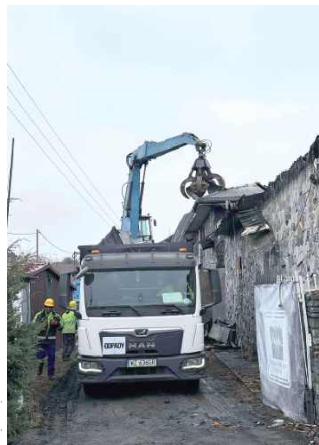
Budynek został doszczętnie zniszczony podczas pożaru
