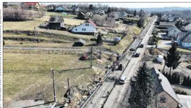
■ Droga powiatowa nr 5021S w przebudowie.
