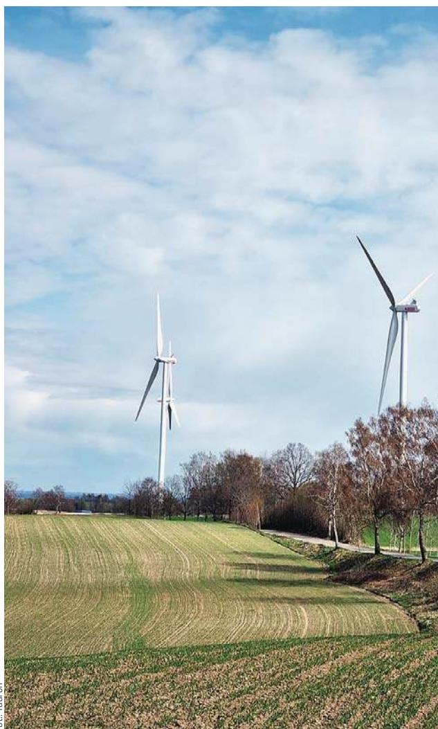
Tauron zakończył montaż turbin farmy wiatrowej Majewo niedaleko Elbląga
