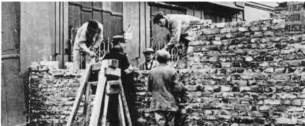
Budowa murów getta na ulicach Warszawy
