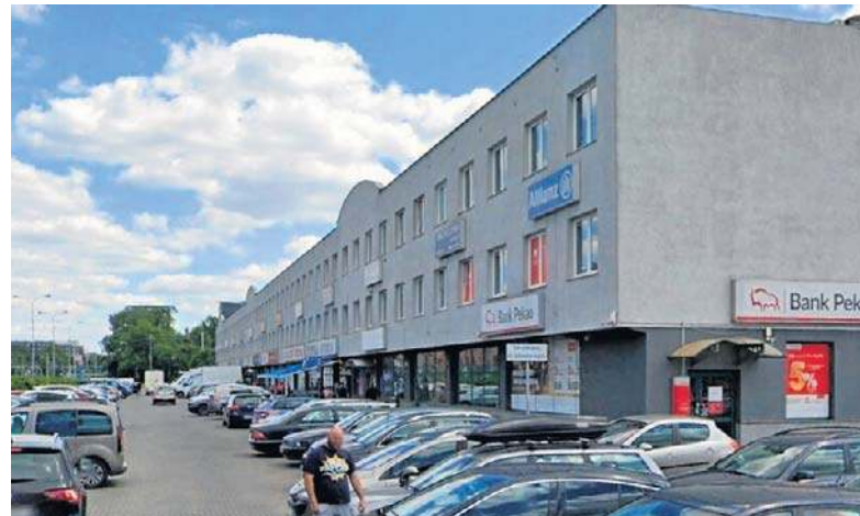
Biurowiec przy Legnickiej 62 zostanie wyburzony
