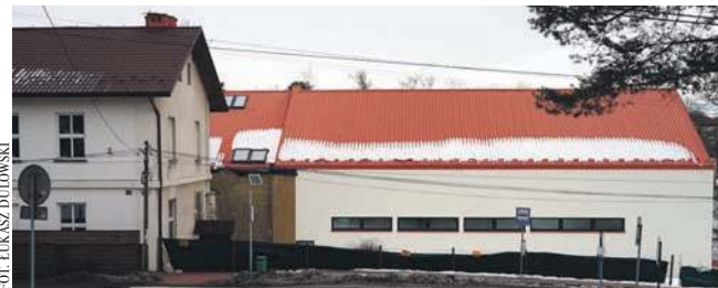
Rozbudowa szkoły w Grojcu ma się zakończyć do 30 listopada 2021 r.
