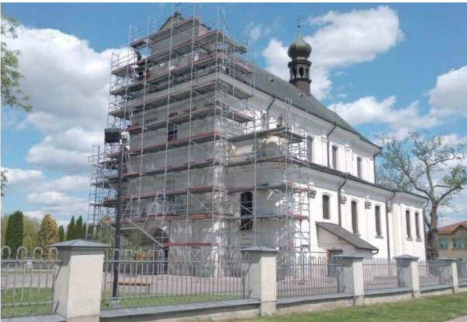
Prace mają na celu m.in. przywrócenie pierwotnej kolorystki elewacji kościoła
