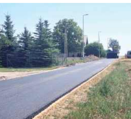
Wkrótce przy nowej jezdni pojawią się utwardzone pobocza
