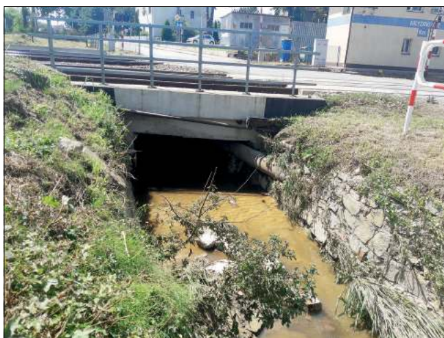
Wylot z głównego odwodnienia Krzyżanowic, o którym wspomina radny powiatowy Łukasz Mura
