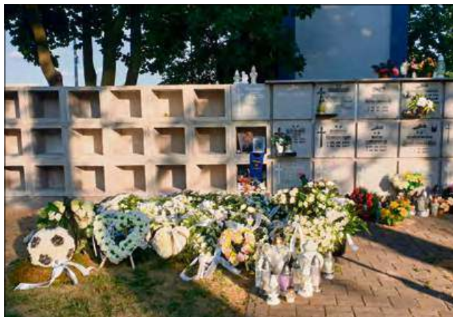
Trwają prace związane z budową kolejnej części kolumbarium na cmentarzu komunalnym w Krapkowicach przy ul. Stanisława Staszica.
