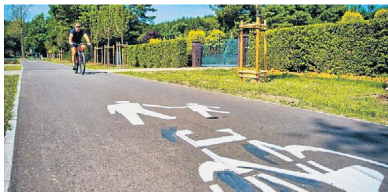
Nowa trasa pieszo-rowerowa przy ul. Wyzwolenia w Bydgoszczy ma powstać w ciągu 4 miesięcy
