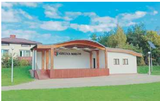
Budynek sceniczny przed remontem
