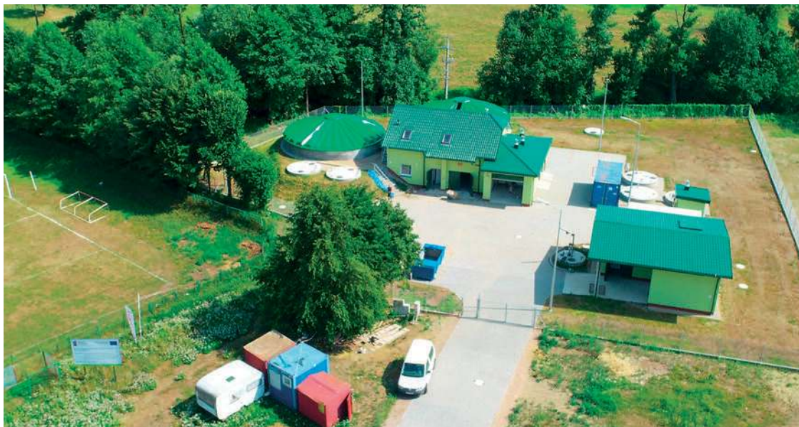
Oczyszczalnia ścieków w Nowym Mieście
