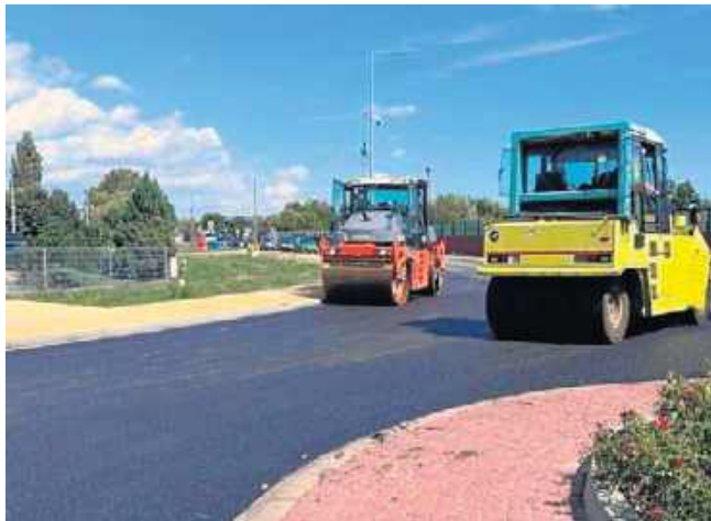
Ulica Portowa już wyremontowana. Na zdjęciu ostatnie prace
