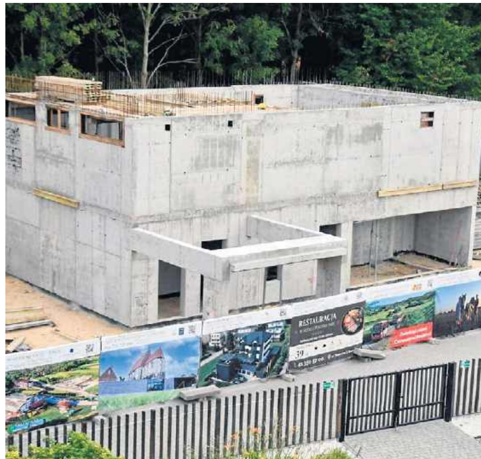
Tak wygląda budowana właśnie część Domu Zdrojowego z korony tężni solankowej
