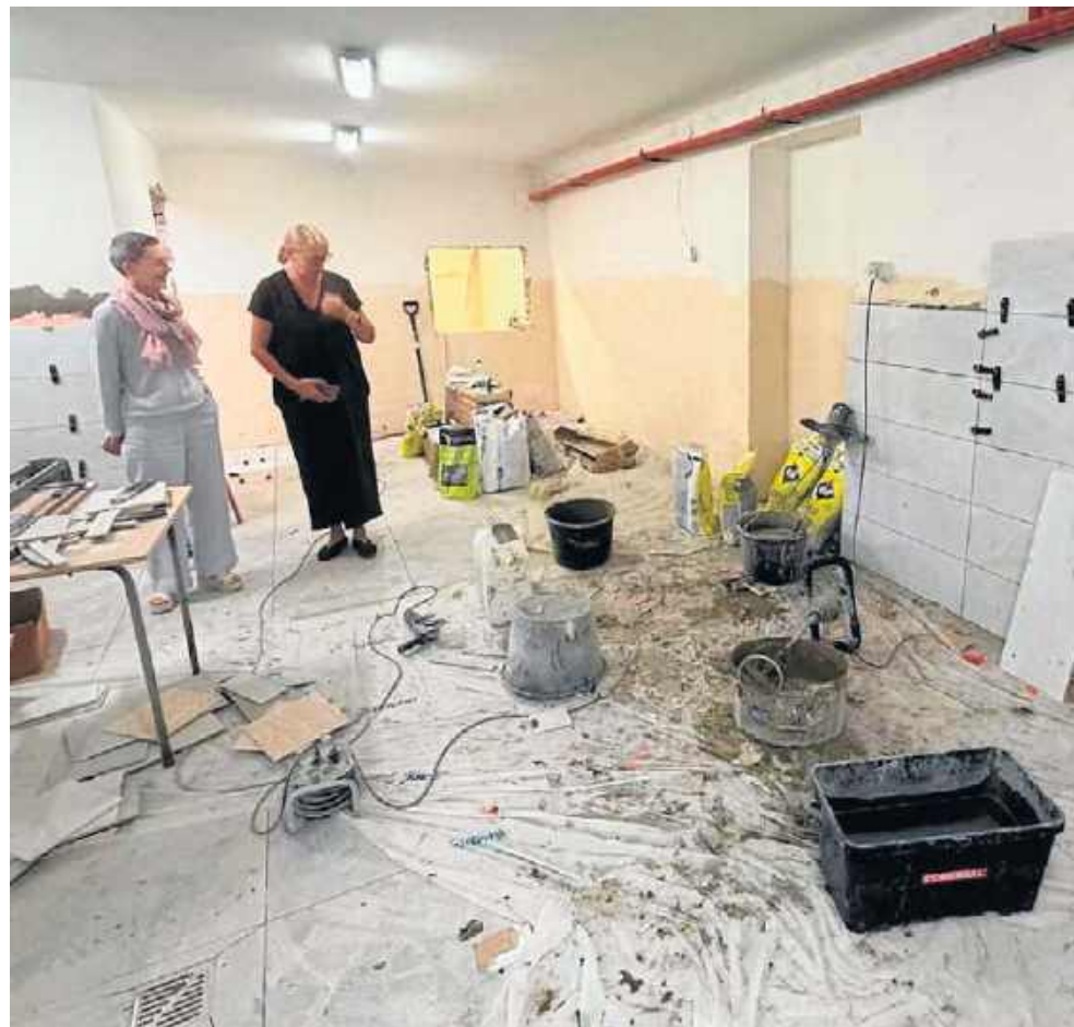
Tak wyglądają prace remontowe w stołówce i kuchni szkolnej.
