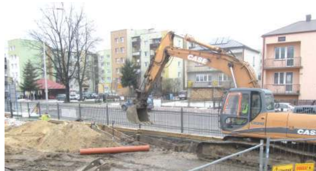
Plac budowy przy Zespole Szkół Budowlanych
