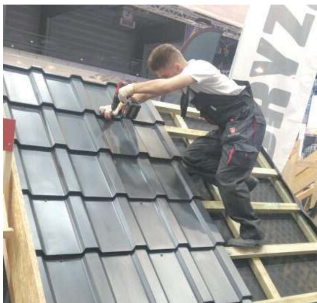
Zawodnicy mieli do wykonania pokrycie dachowe z blachodachówki modułowej z montażem obróbek blacharskich i wykonanie attyki
