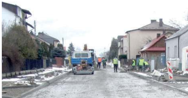
Przebudowa ul. Piłsudskiego w Biłgoraju
