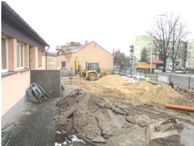
Plac budowy przy Zespole Szkół Budowlanych
