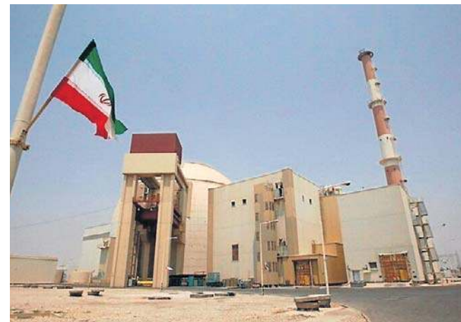
Buszehr to kluczowa irańska elektrownia jądrowa. Została uszkodzona po ataku rakietowym
