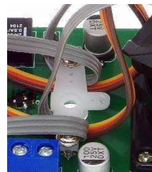
Fotografia 1. Mocowanie przewodów do dużej płytki
