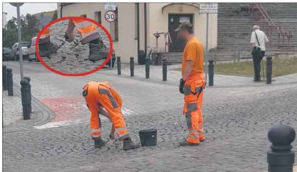
Kolejne naprawy na jaworznickim rynku
