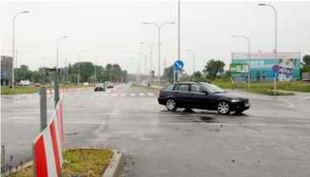
Przedłużenie ul. Lubelskiego Lipca '80 to, po przebudowie układu komunikacyjnego wokół powstającego dworca metropolitalnego, priorytetowa inwestycja drogowa w tej części miasta
