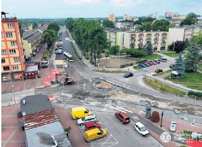
Na skrzyżowaniu ulic Wybickiego, Wiśniowej, Prusa i Tiereszkowej trwa budowa ronda
