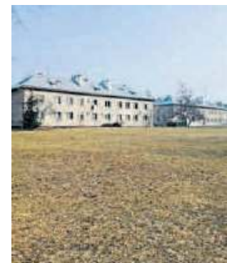
W tym miejscu na osiedlu Gaj powstanie nowy blok socjalny
