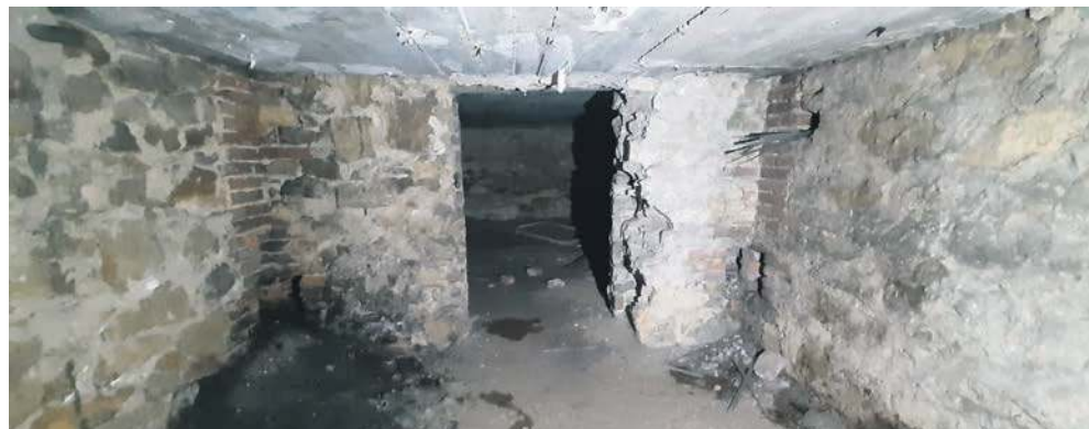
Piwnica i stare fundamenty budynku
