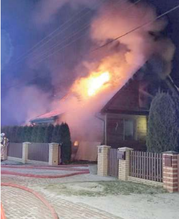
- W chwili przybycia straży pożarnej dom był już objęty pożarem. Działania straży polegały na gaszeniu wodą płonącego budynku i obronie sąsiednich budynków na działce. W pożarze nikt nie ucierpiał, ale straty są duże, spłonęło wnętrze budynku i konstrukcja dachu - informuje kpt. Michał Mazur z KP PSP Lubartów
