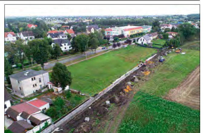
Tak postępują prace w Gogolinie-Karłubcu.
