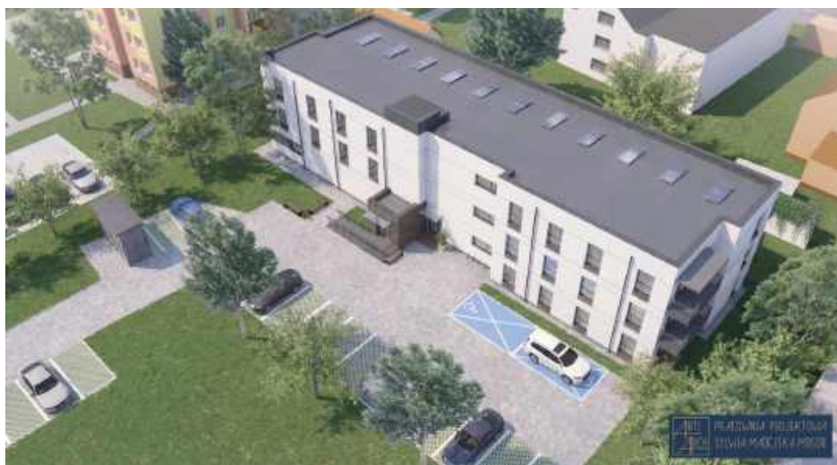
23 marca br. inwestor uzyskał prawomocne pozwolenie na budowę, co otwiera drogę do rozpoczęcia kolejnych etapów przedsięwzięcia
