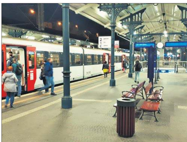
Przebudowana stacja Gdańsk Główny
