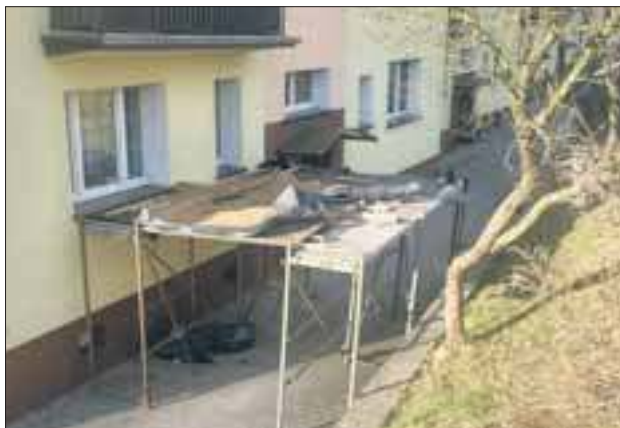
Konstrukcję zbudowano celem ochrony przed spadającym śniegiem
