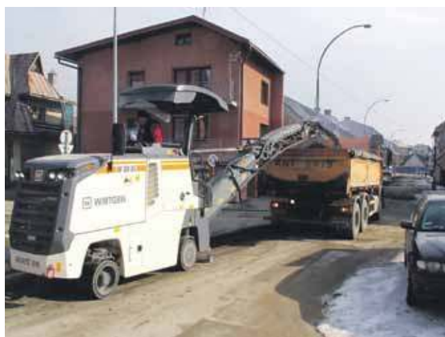
Drogowcy zdzierają asfalt na Długiej.
