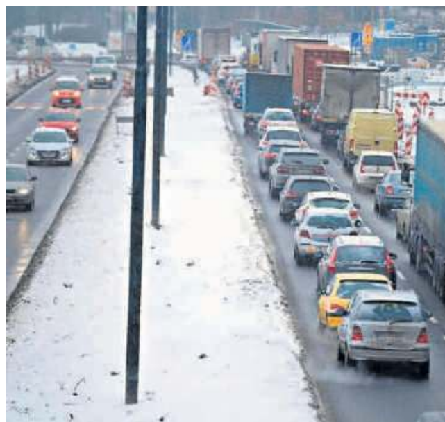
Zimowe warunki utrudniają też prace na budowie Trasy Łagiewnickiej i przy rozbudowie al. 29 Listopada
