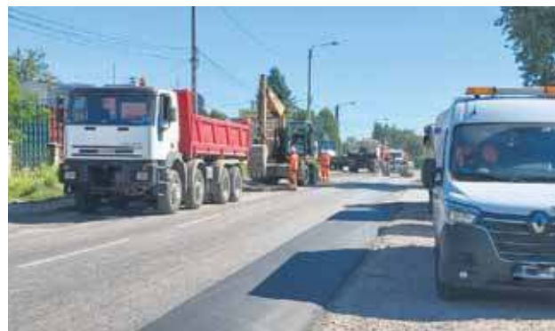
Trwający remont kanalizacji powoli dobiega końca
