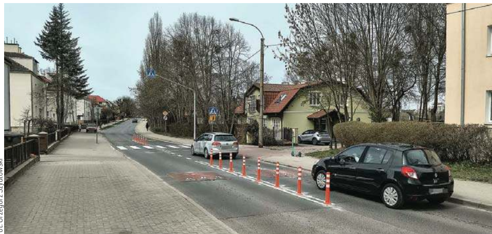
Bezpieczne przejście dla pieszych przez ul. Jagiellończyka w Olsztynie
