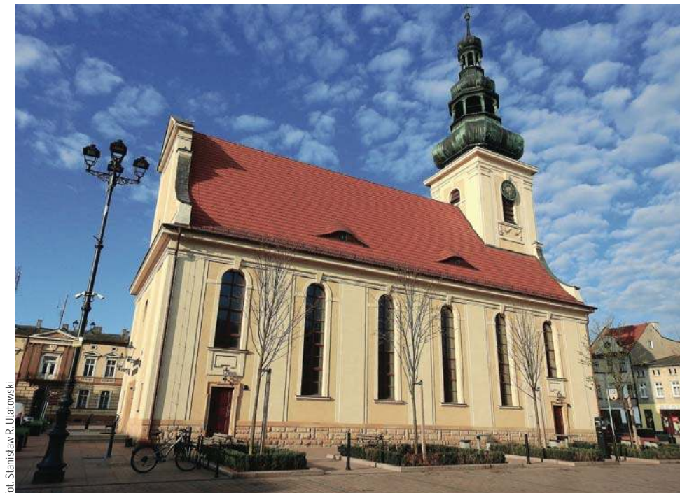
Widok obecny budowli kościoła poewangelickiego, w którym funkcjonuje Kinoteatr Harmonia
