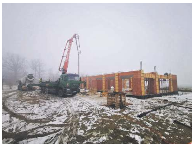
Na budowie w Krościnie Małej trwają roboty budowlane
