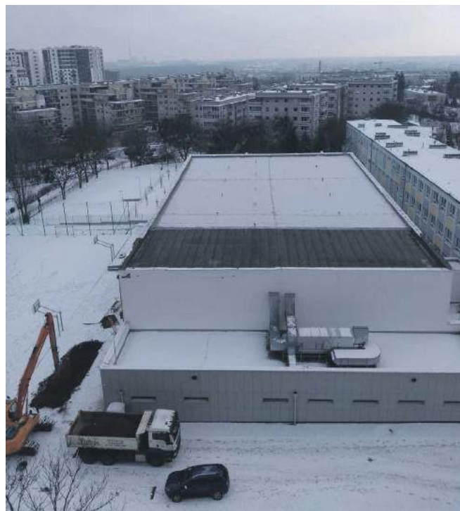
Prace na dachu poznańskiej hali sportowej trwają
