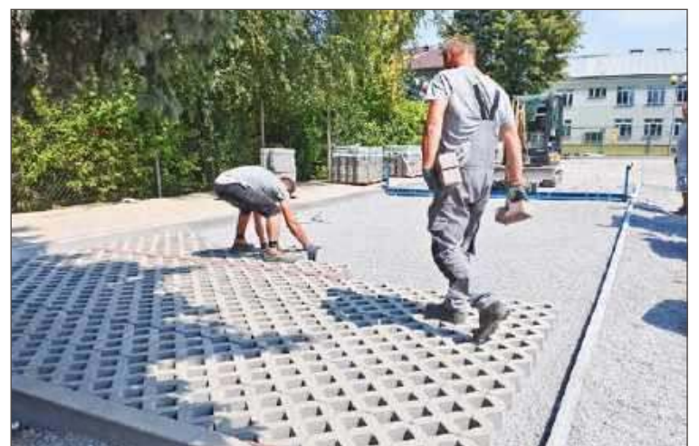
Po zakończeniu prac będzie tu miejsce na 29 samochodów.
