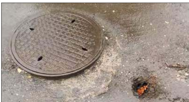
Studzienka jest cyklicznie podmywana, a ziemia wypłukiwana.
