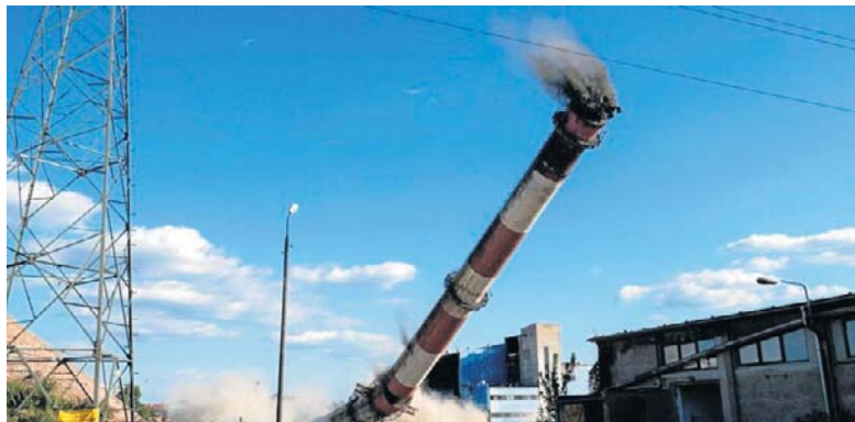
Komin miał średnicę zewnętrzną około 6 metrów u podstawy
