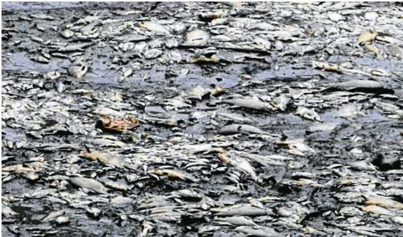
• Po niemal całkowitym spuszczeniu wody ze zbiornika w Zalewie Pilchowickim, prowadzonym w związku z remontem ponadstuletniej zapory, odsłonięte dno pokryły tysiące śniętych ryb
