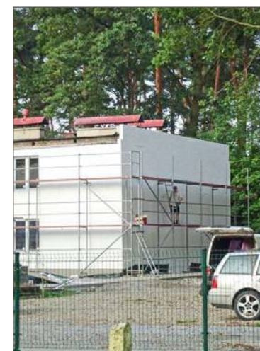
Remont już się rozpoczął.
