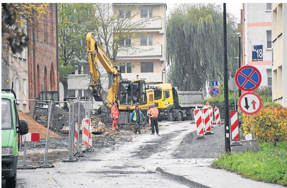
To krótki odcinek drogi, ale z długą historią pod ziemią, co spowalnia wykonawcę
