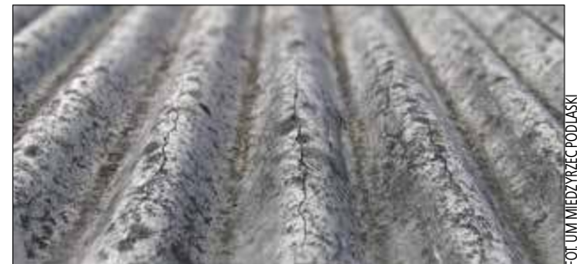
Od 1 do 31 marca mieszkańcy miasta mogą składać wnioski o pomoc w usunięciu pokryć dachowych, zawierających azbest
