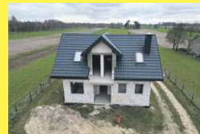
Dom w stanie surowym otwartym, Wólka Siemieńska, 885 851 160
