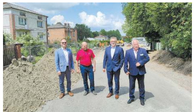
Budowa drogi powiatowej w Rudzie-Hucie
