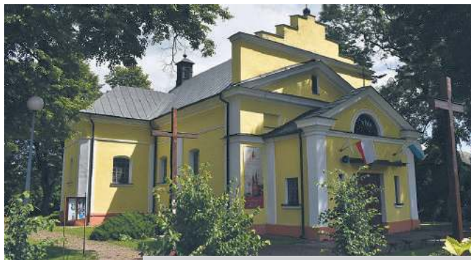
Parafia w Uhrusku dostanie ok. 400 tys. zł na remont elewacji zewnętrznej
