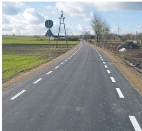
Przebudowa 23 odcinków dróg o długości ponad 21 km
