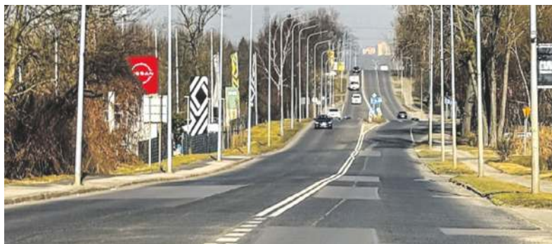
Naprawa uszkodzonej jezdni ucieszy kierowców
