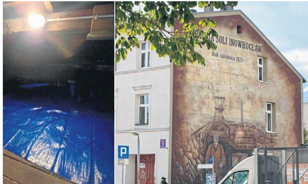
Mieszkańcy rozpoczęli zabezpieczanie strychu przy pomocy plandek
