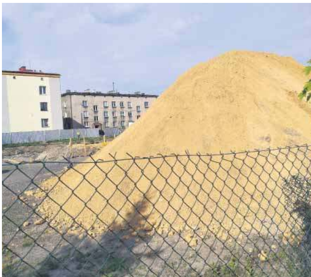
Budowa dopiero się rozpoczęła
